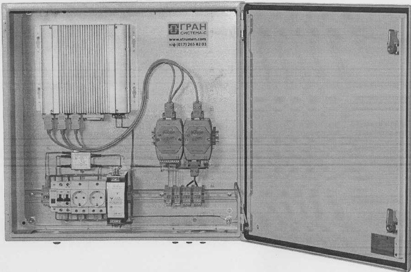
Рисунок 2 – Внешний вид УСПД «ГРАН-ЭЛЕКТРО XXX/X/X-IP54»
