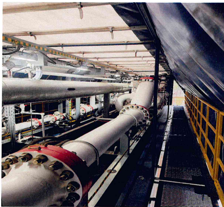
Рисунок 1.1 – Фотография общего вида трубопоршневой поверочной установки двунаправленной OGSB № 347
