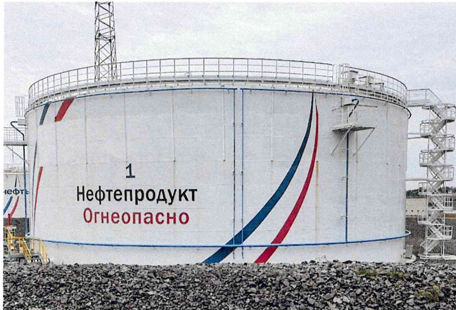
Рисунок 1.1 – Фотография общего вида резервуара РВС-10000 № 1
