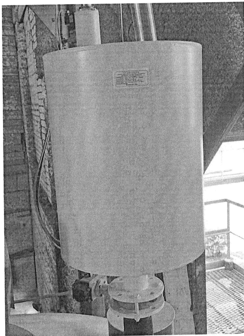
Рисунок 1.1 – Фотография внешнего вида дозатора весового дискретного действия для дозирования воды типа ДВДв № 003
