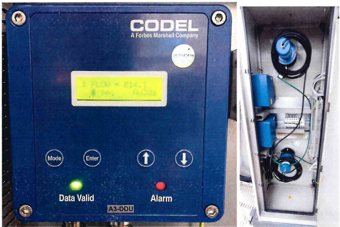
Рисунок 1.5 – Фотография общего вида измерителя скорости газоздушных потоков инфракрасный VCEM5100
