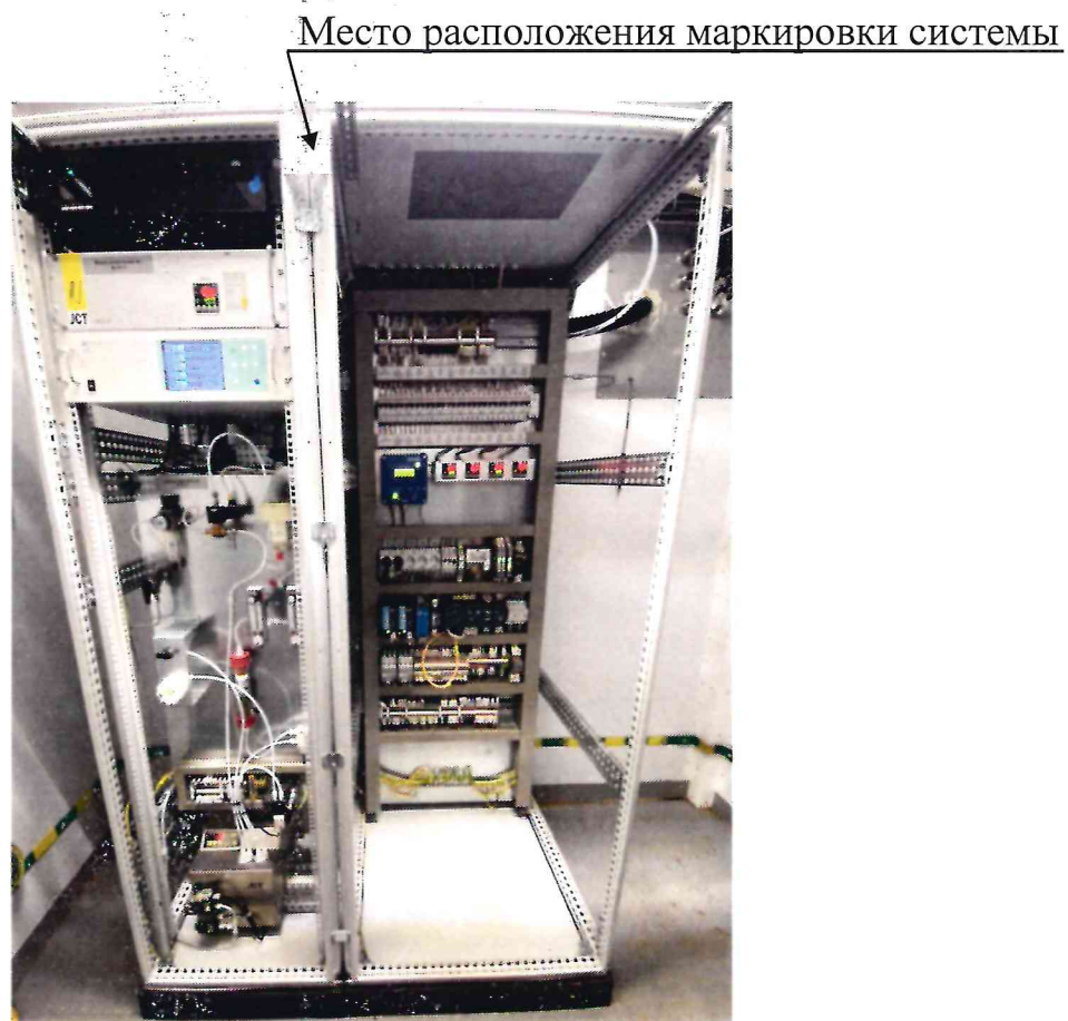
Рисунок 1.7 – Общий вид шкафа с аналитическим и коммутационным оборудованием системы газоаналитической промышленной взрывозащищенной PromIS GA Ex № 370-01
