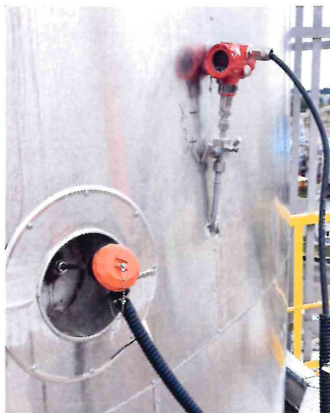
Рисунок 1.2 – Общий вид датчика давления Агат-100МТ и датчика температуры ТСПУ-3218
