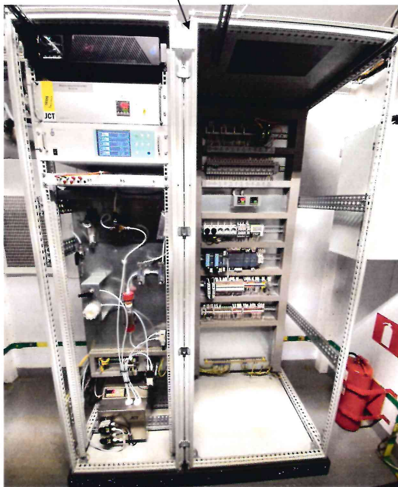
Рисунок 1.7 – Общий вид шкафа с аналитическим и коммутационным оборудованием системы газоаналитической промышленной PromIS GA № 370-02
