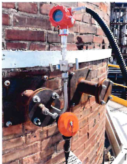
Рисунок 1.2 – Общий вид датчика давления Агат-100МТ и датчика температуры ТСПУ-3218
