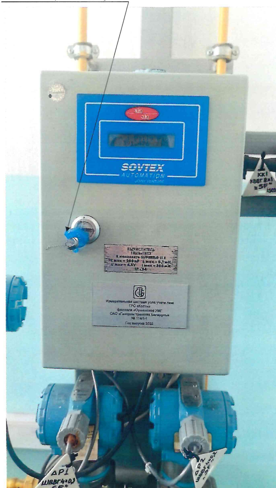
Рисунок 3.1 – Схема (фотография) пломбировки от несанкционированного доступа.
