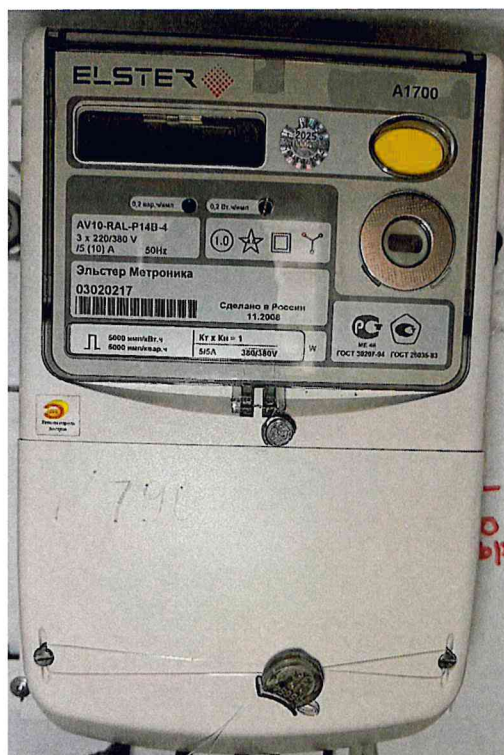
Рисунок 1.2 – Фотографии счётчиков, входящих в состав измерительных каналов АСКУЭ (изображение носит иллюстративный характер)
