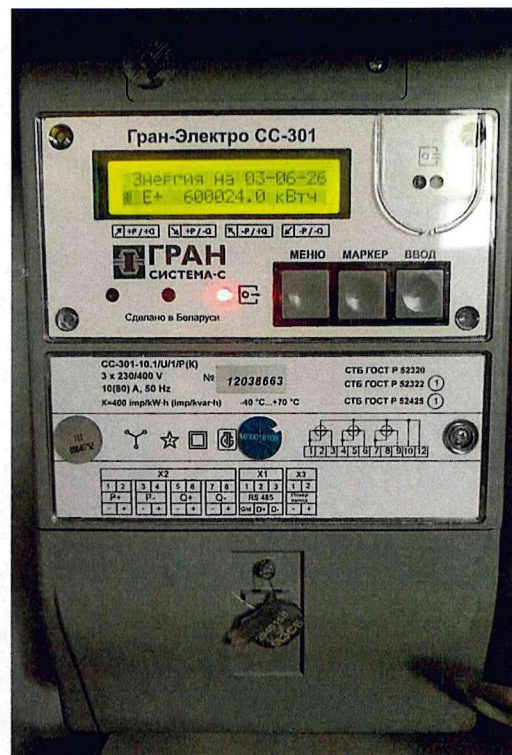
Рисунок 1.2 – Фотографии счётчиков, входящих в состав измерительных каналов АСКУЭ (изображение носит иллюстративный характер)
