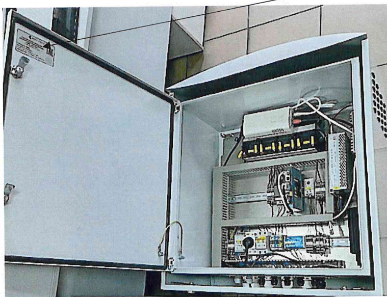
Рисунок 1.3 – Фотография общего вида коммуникационного шкафа системы метеорологической автоматической информационной АМИС «МетПро» (изображение носит иллюстративный характер)
