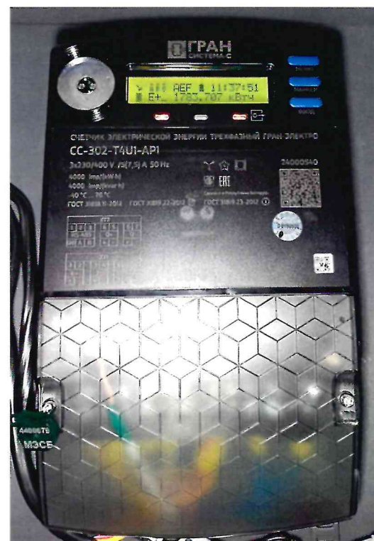
Рисунок 1.2 – Фотографии счётчиков, входящих в состав измерительных каналов АСКУЭ (изображение носит иллюстративный характер)
