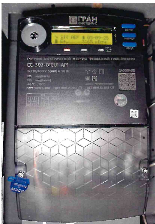
Рисунок 1.2 – Фотографии счётчиков, входящих в состав измерительных каналов АСКУЭ (изображение носит иллюстративный характер)
