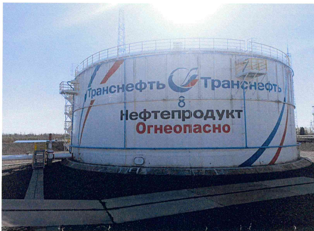
Рисунок 1.1 – Фотография общего вида резервуара РВС-10000 № 8
