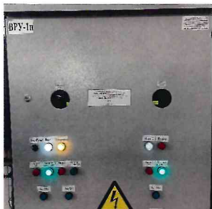
а) маркировочная табличка АСКУЭ на шкафу со счётчиками
