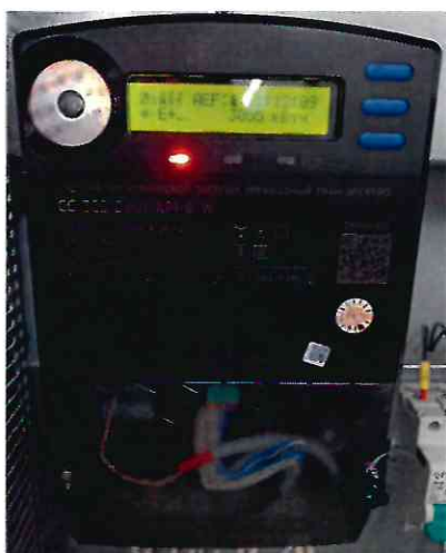
б) счётчики, входящие в состав измерительных каналов АСКУЭ (изображения носят иллюстративный характер)
