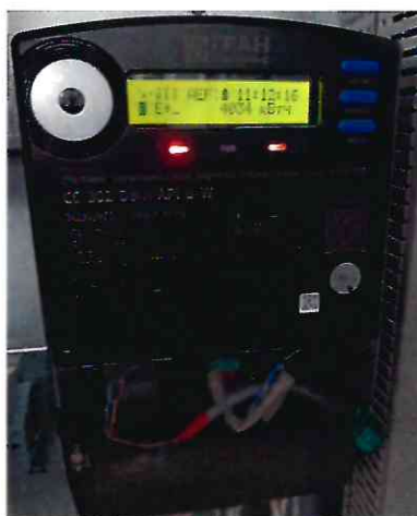
б) счётчики, входящие в состав измерительных каналов АСКУЭ (изображения носят иллюстративный характер)
