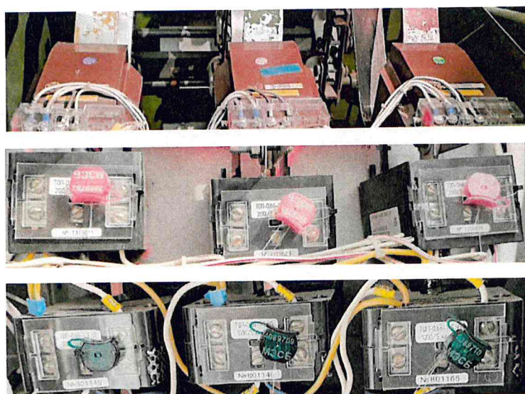
Рисунок 1.2 – Фотографии общего вида трансформаторов тока (изображения носят иллюстративный характер)
