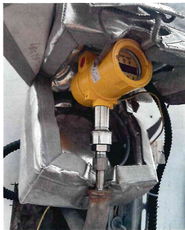
Рисунок 1.1 – Фотографии общего вида компонентов из состава АСКВ (подсистема измерения расхода отходящих газов, изображения носят иллюстративный характер)
