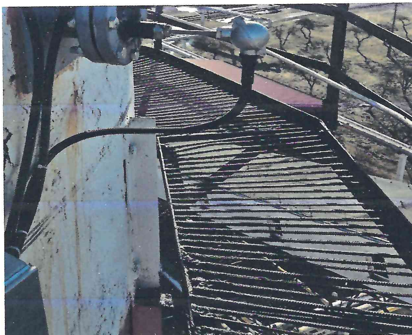
Рисунок 1.5 – Фотография общего вида термопреобразователя сопротивления ТС-Б-У (Система автоматизированная контроля выбросов загрязняющих веществ № ECS-25.132-01)
