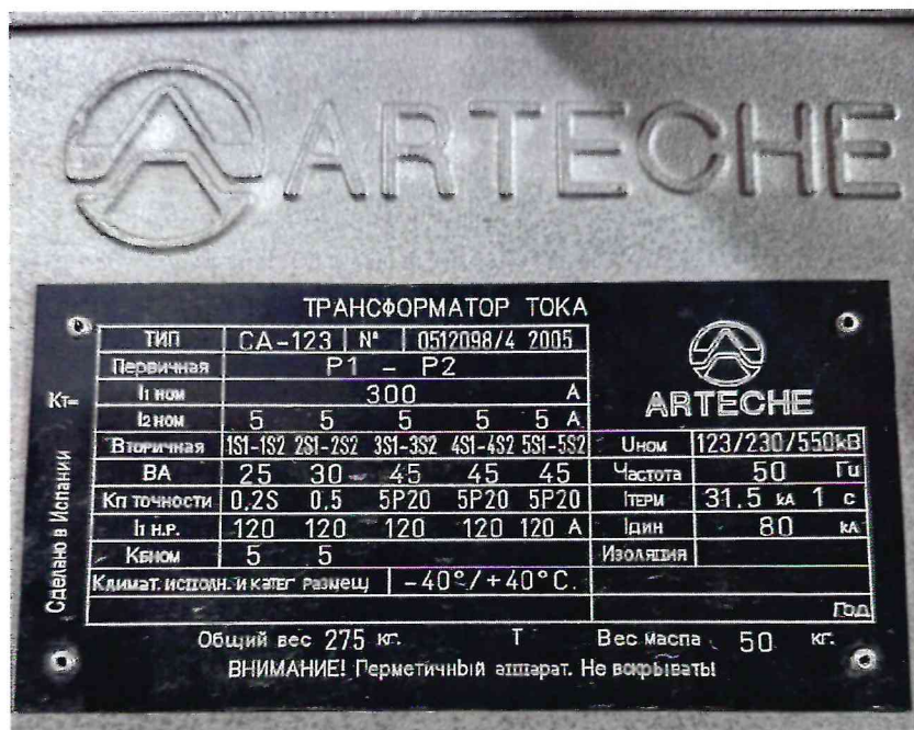
Рисунок 1.2 – Фотография маркировки трансформатора тока СА-123 № 0512098/4
