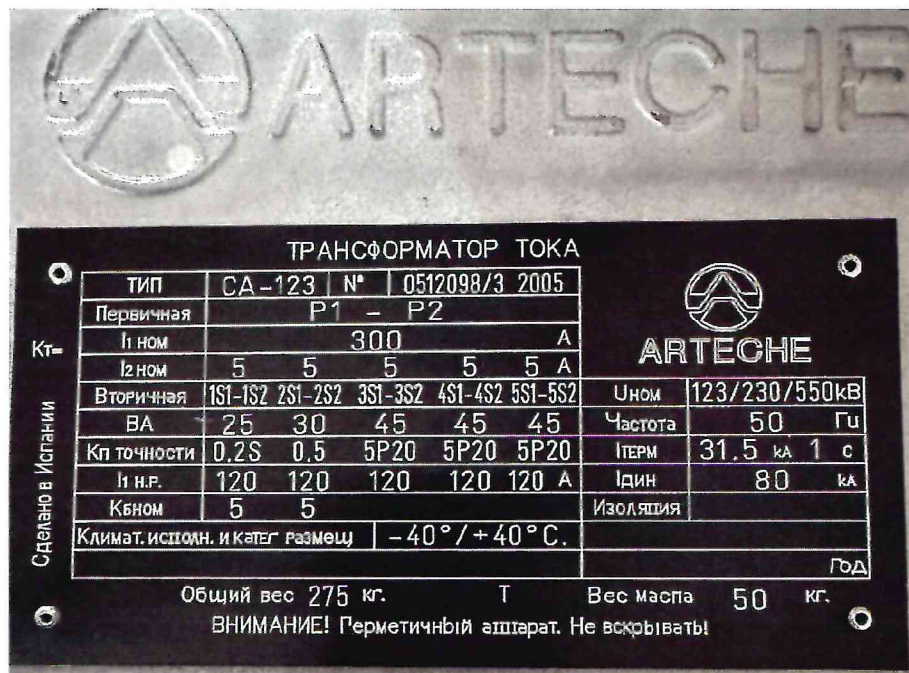
Рисунок 1.2 – Фотография маркировки трансформатора тока СА-123 № 0512098/3
