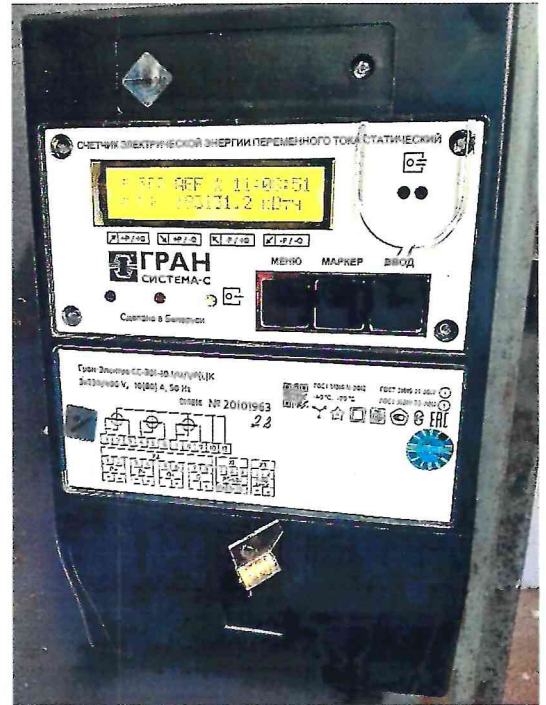
Рисунок 1.2 – Фотографии счётчиков, входящих в состав измерительных каналов АСКУЭ (изображения носят иллюстративный характер)
