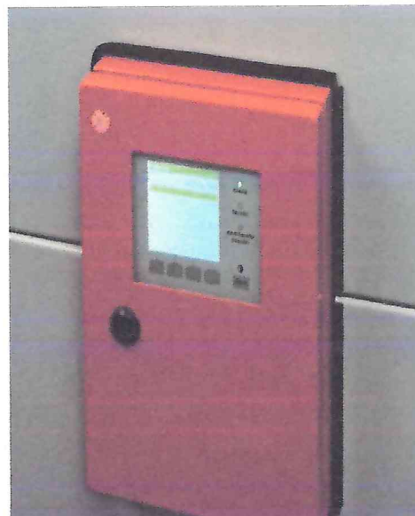
Рисунок 1.5 – Фотография общего вида преобразователя температуры СТР-6 (Система автоматизированного контроля и учета выбросов загрязняющих веществ в атмосферный воздух от дымовой трубы ДСП-250 (электрофильтр мокрой очистки) источник №0026 ОАО «Ивацевичдрев» № СЭ.11081.АСК.001.УХЛ1)
