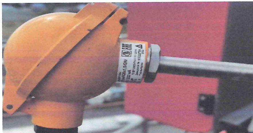
Рисунок 1.5 – Фотография общего вида преобразователя температуры СТР-6 (Система автоматизированного контроля и учета выбросов загрязняющих веществ в атмосферный воздух от дымовой трубы ДСП-250 (электрофильтр мокрой очистки) источник №0026 ОАО «Ивацевичдрев» № СЭ.11081.АСК.001.УХЛ1)
