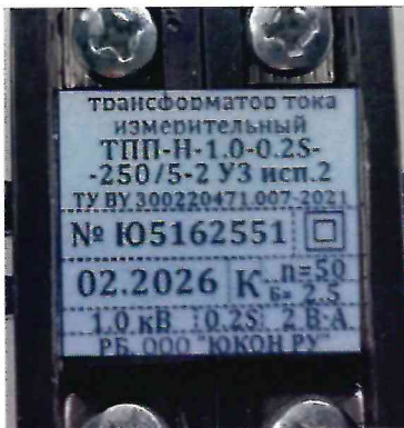
Рисунок 1.1 – Фотографии общего вида трансформаторов тока измерительных ТПП и ТПП-Н (изображение носит иллюстративный характер)
