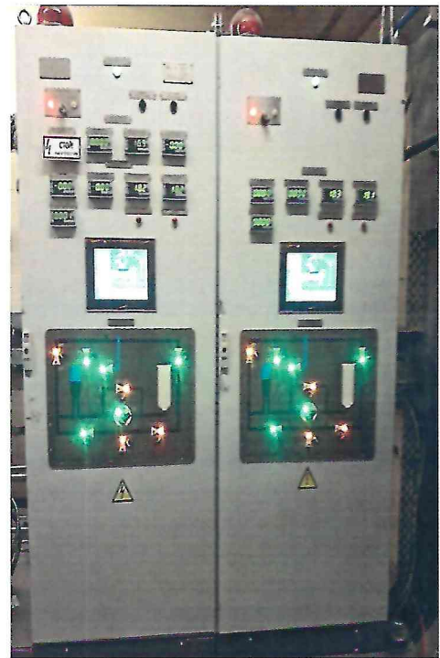
а) электротехнические шкафы управления системой (в качестве АРМ используется лицевая часть стойки: на рисунке справа)
