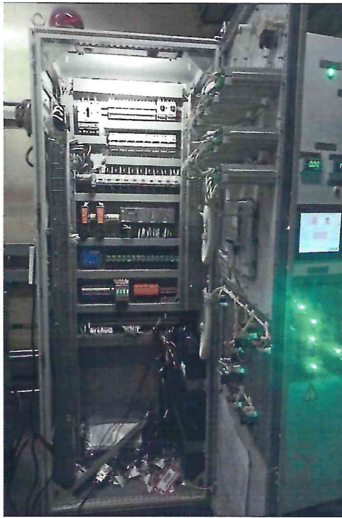
а) электротехнические шкафы управления системой (в качестве АРМ используется лицевая часть стойки: на рисунке справа)
