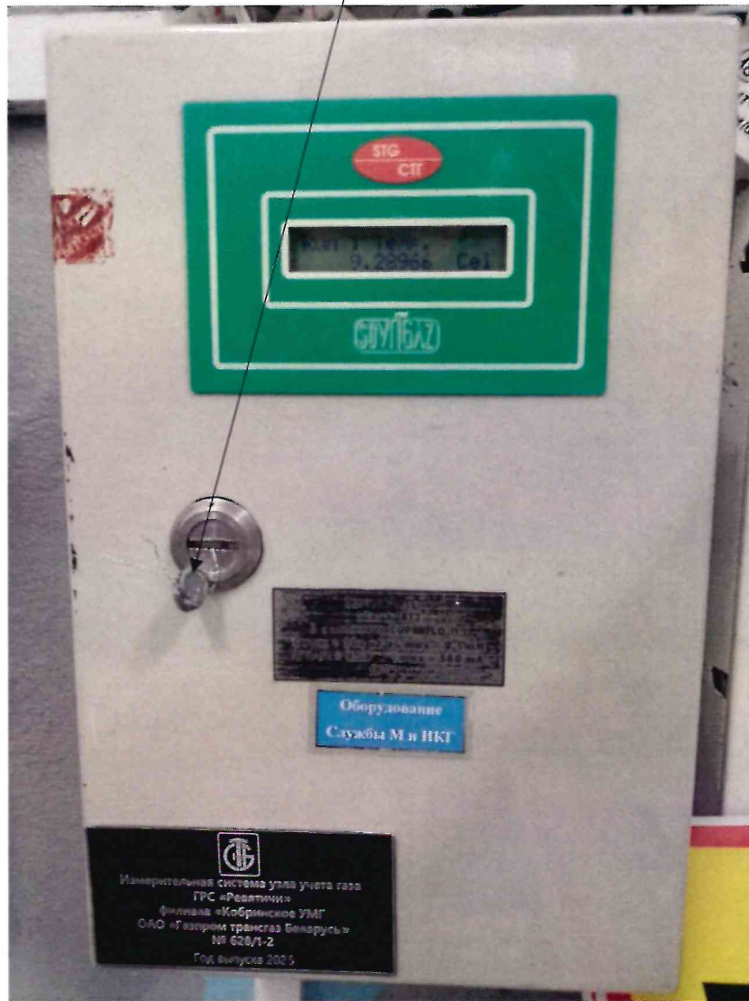
Рисунок 3.1 – Схема (фотография) пломбировки от несанкционированного доступа.
