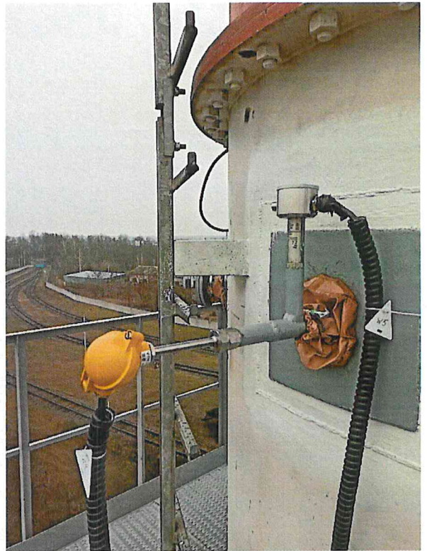
б) преобразователь температуры СТР-6 и преобразователь давления РС-28
