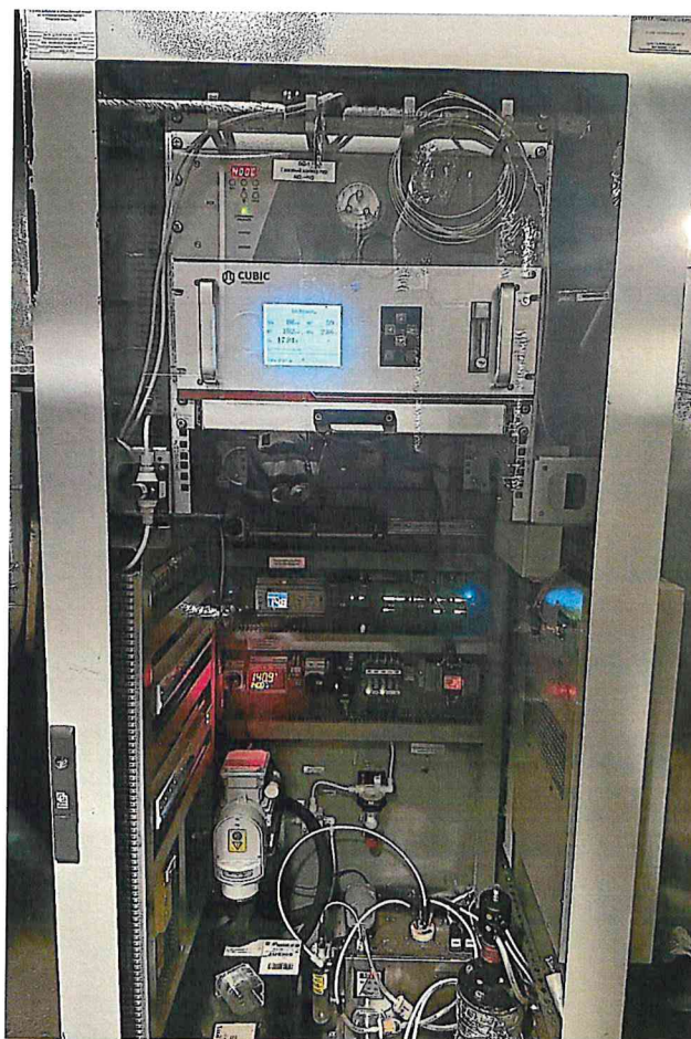
Рисунок 1.3 – Фотография общего вида компонентов из состава АСКВ (шкаф газового анализа, изображение носит иллюстративный характер)
