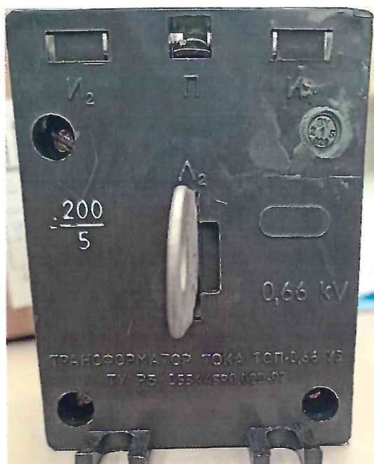
Рисунок 1.3 – Фотография маркировки трансформаторов тока TOP-0,66УЗ (изображение носит иллюстративный характер)
