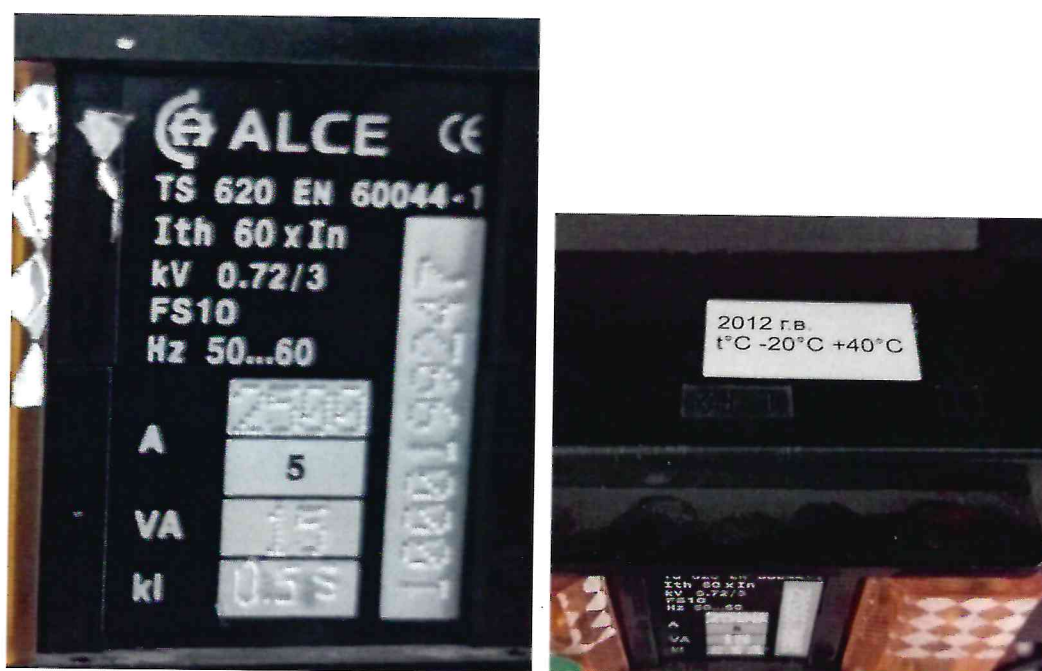
Рисунок 1.2 – Внешний вид маркировки трансформатора тока TS 620 EN № 1000199247
