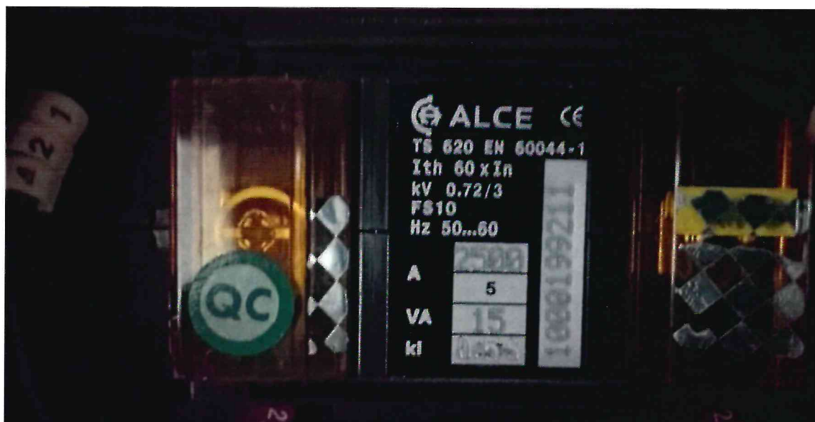
Рисунок 1.1 – Внешний вид трансформатора тока TS 620 EN № 1000199211
