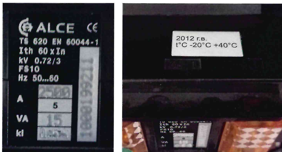
Рисунок 1.2 – Внешний вид маркировки трансформатора тока TS 620 EN № 1000199211
