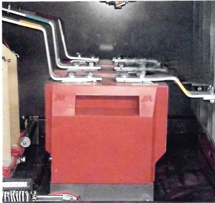
Рисунок 1.3 – Фотография общего вида трансформаторов тока (изображение носит иллюстративный характер)
