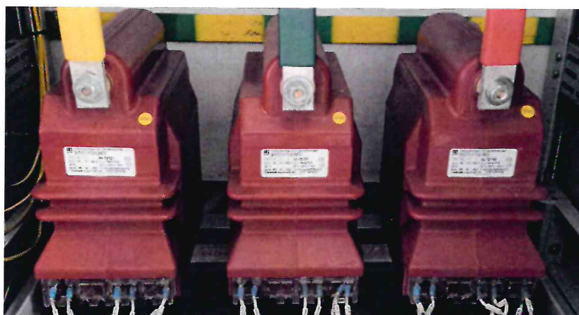
Рисунок 1.2 – Фотография общего вида трансформаторов напряжения (изображение носит иллюстративный характер)
