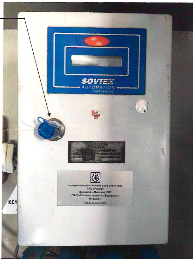
Рисунок 3.1 – Схема пломбировки от несанкционированного доступа
