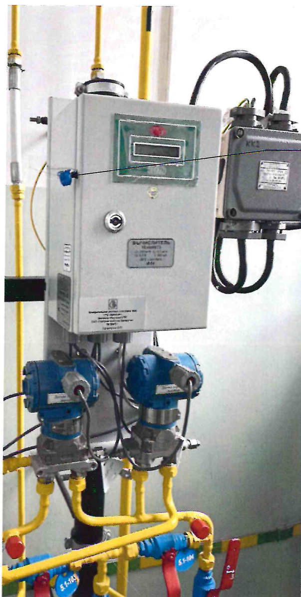
Рисунок 3.1 – Схема пломбировки от несанкционированного доступа
