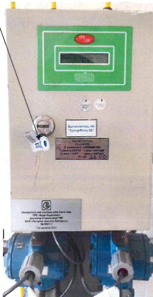
Рисунок 3.1 – Схема пломбировки от несанкционированного доступа
