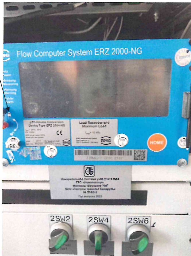
Рисунок 3.1 – Схема пломбировки от несанкционированного доступа
