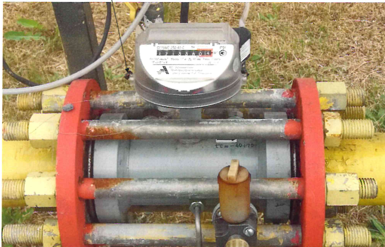
Рисунок 3.1 – Схема пломбировки от несанкционированного доступа
