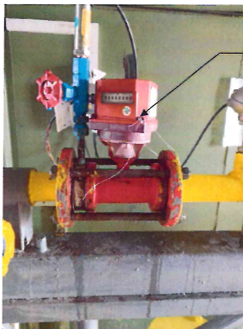
Рисунок 3.1 – Схема пломбировки от несанкционированного доступа
