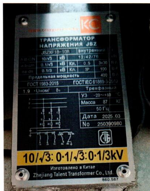
Рисунок 1.2 – Фотография маркировки трансформаторов напряжения JSZ (изображение носит иллюстративный характер)
