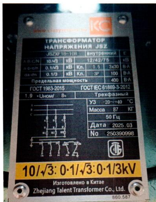
Рисунок 1.2 – Фотография маркировки трансформаторов напряжения JSZ (изображение носит иллюстративный характер)
