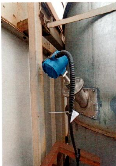
а) расходомер-счетчик ультразвуковой УРГ-810-250
