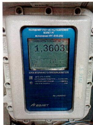
а) расходомер-счетчик ультразвуковой УРГ-810-250
