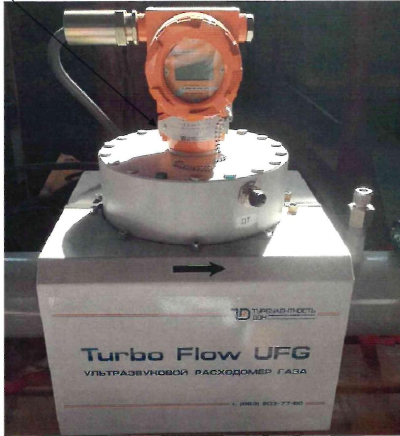
Рисунок 3.1 – Схема пломбировки от несанкционированного доступа
