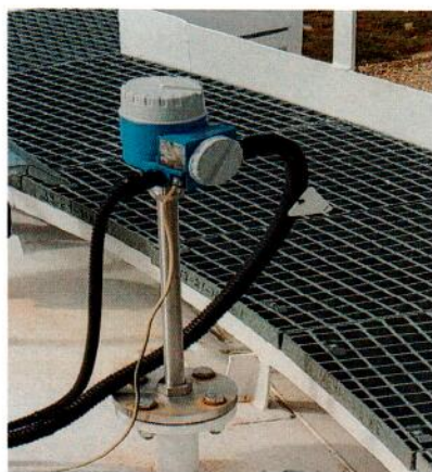
Рисунок 1.5 – Внешний вид и образец маркировки преобразователя температуры Prothermo из состава системы (изображения носят иллюстративный характер)
