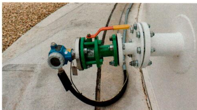
Рисунок 1.6 – Внешний вид и образец маркировки преобразователя гидростатического давления из состава системы (изображения носят иллюстративный характер)
