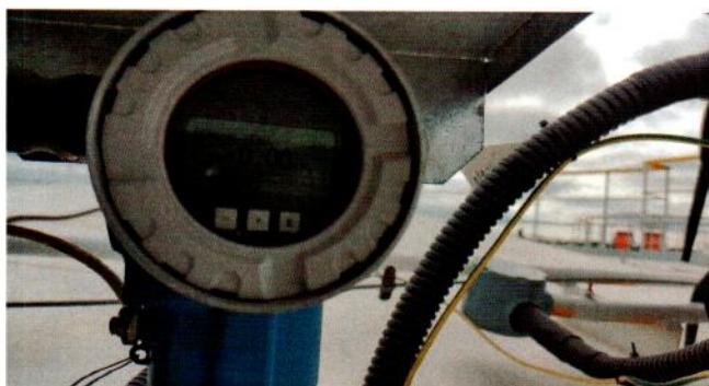
Рисунок 1.7 – Внешний вид и образец маркировки преобразователя давления паров из состава системы (изображения носят иллюстративный характер)
