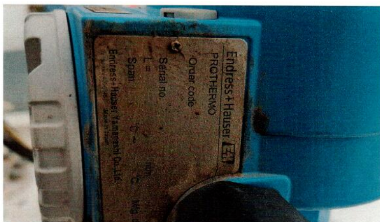
Рисунок 1.5 – Внешний вид и образец маркировки преобразователя температуры Prothermo из состава системы (изображения носят иллюстративный характер)
