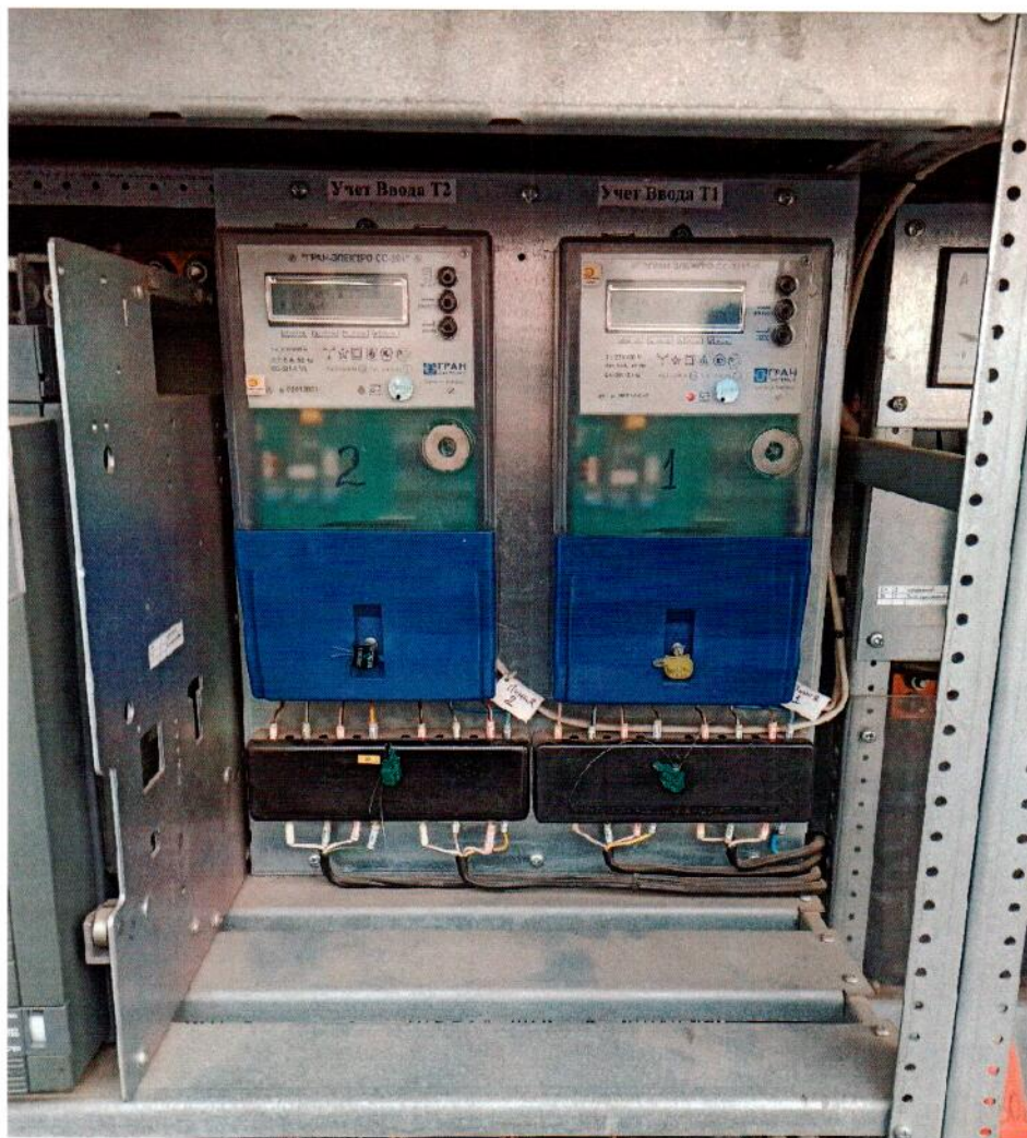
Рисунок 1.2 – Фотографии счётчиков, входящих в состав измерительных каналов АСКУЭ (изображение носит иллюстративный характер)
