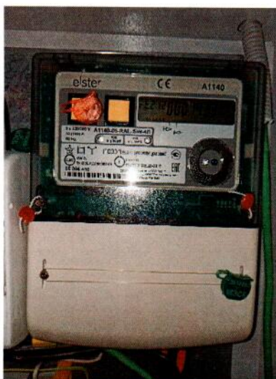
Рисунок 1.2 – Фотографии счётчиков, входящих в состав измерительных каналов АСКУЭ (изображения носят иллюстративный характер)
