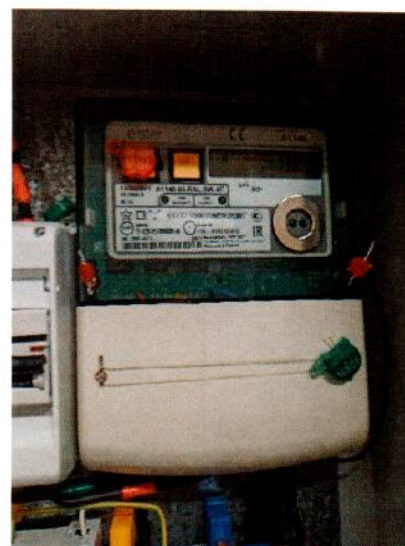
Рисунок 1.2 – Фотографии счётчиков, входящих в состав измерительных каналов АСКУЭ (изображения носят иллюстративный характер)
