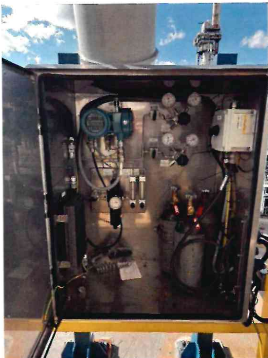
а) двери открыты, блок управления анализатора кислорода OxyMitter 4000
