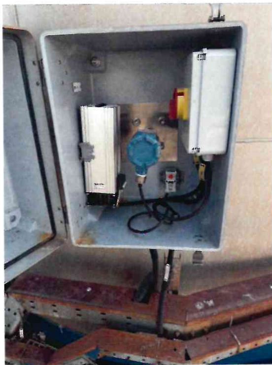
а) преобразователь давления измерительный 2600T 266MST
