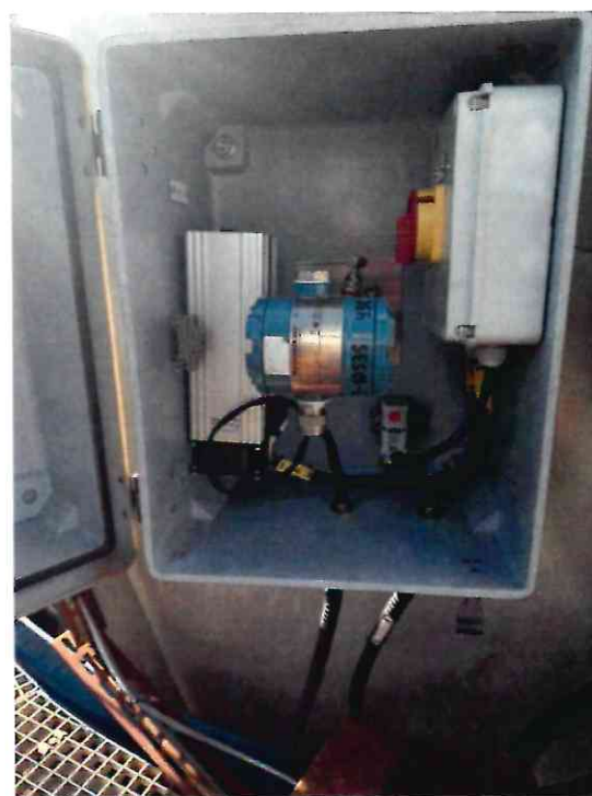
б) преобразователь давления измерительный 2051TA
