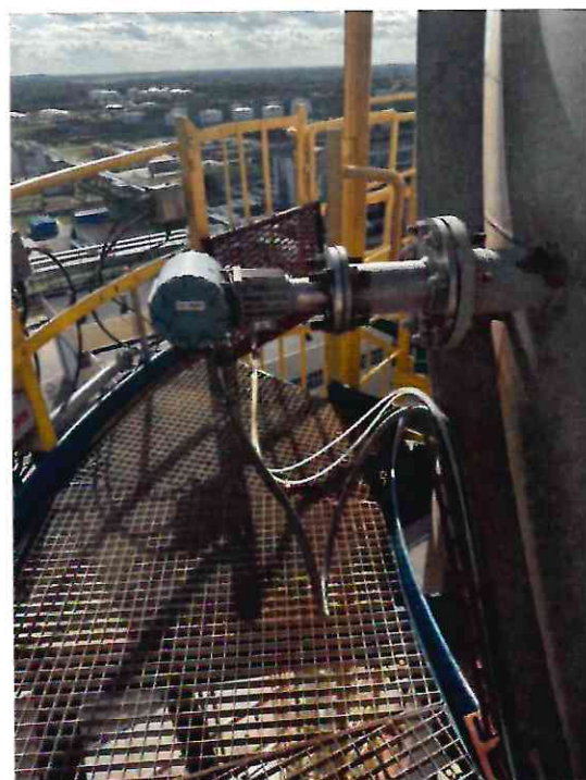
г) измерительный зонд анализатора кислорода Oxymitter 4000
