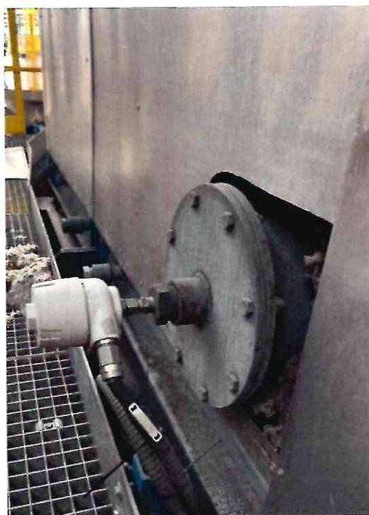
в) преобразователь температуры измерительный Rosemount 248 с преобразователем термоэлектрическим Rosemount 0185
