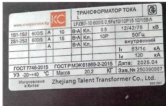
Рисунок 1.2 – Фотографии маркировки трансформаторов тока L (изображение носит иллюстративный характер)
