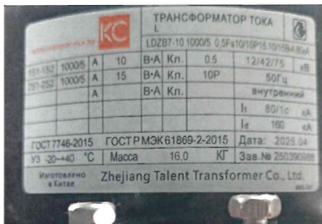
Рисунок 1.2 – Фотографии маркировки трансформаторов тока L (изображение носит иллюстративный характер)
