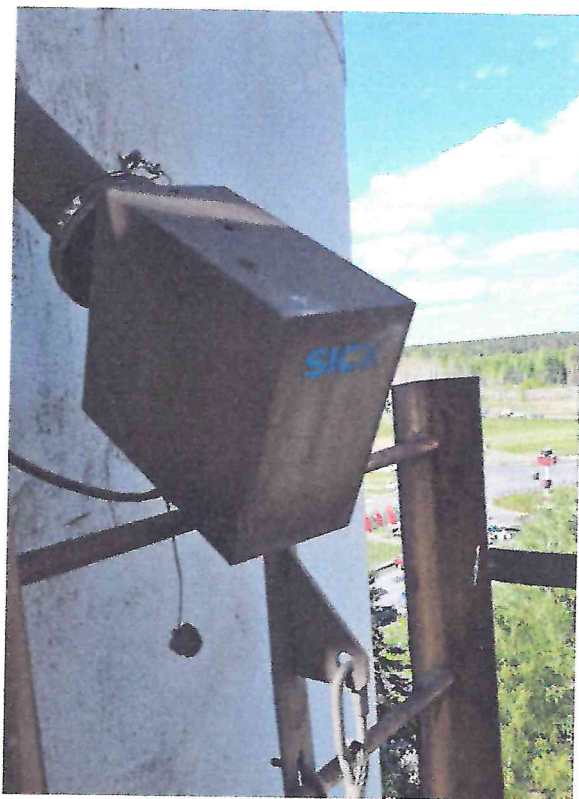
Рисунок 1.3 – Фотография датчиков измерителя скорости газового потока. Система автоматизированная контроля и учета выбросов № СЭ.20322.АСК.002.УХЛ1 от дымовой трубы ДСП-2 ист. выбросов № 0002. ОАО «БМЗ» № СЭ.20322.АСК.002.УХЛ1
