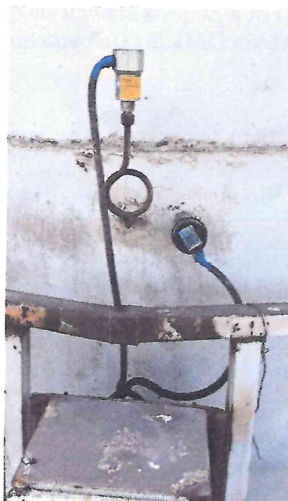
Рисунок 1.5 – Фотография преобразователя давления и термопреобразователя. Система автоматизированная контроля и учета выбросов № СЭ.20322.АСК.002.УХЛ1 от дымовой трубы ДСП-2 ист. выбросов № 0002. ОАО «БМЗ» № СЭ.20322.АСК.002.УХЛ1
