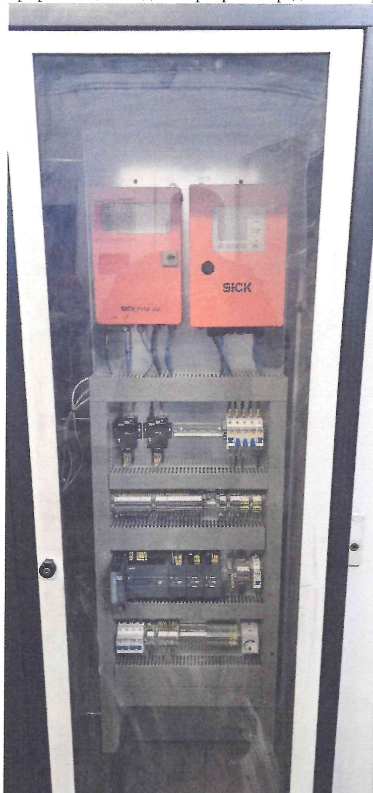
Рисунок 1.1 – Фотография шкафа вторичных преобразователей. Система автоматизированная контроля и учета выбросов № СЭ.20322.АСК.001.УХЛ1 от дымовой трубы ДСП 1 ист. выбросов № 0001. ОАО «БМЗ» № СЭ.20322.АСК.001.УХЛ1
