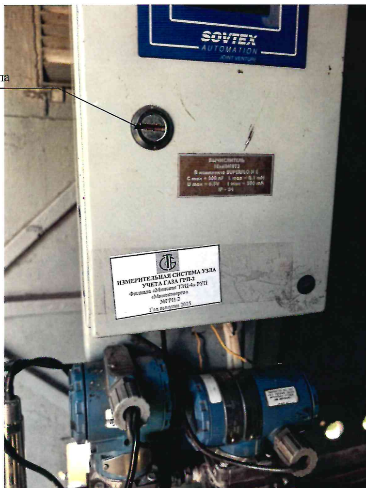
Рисунок 3.1 – Схема пломбировки от несанкционированного доступа
