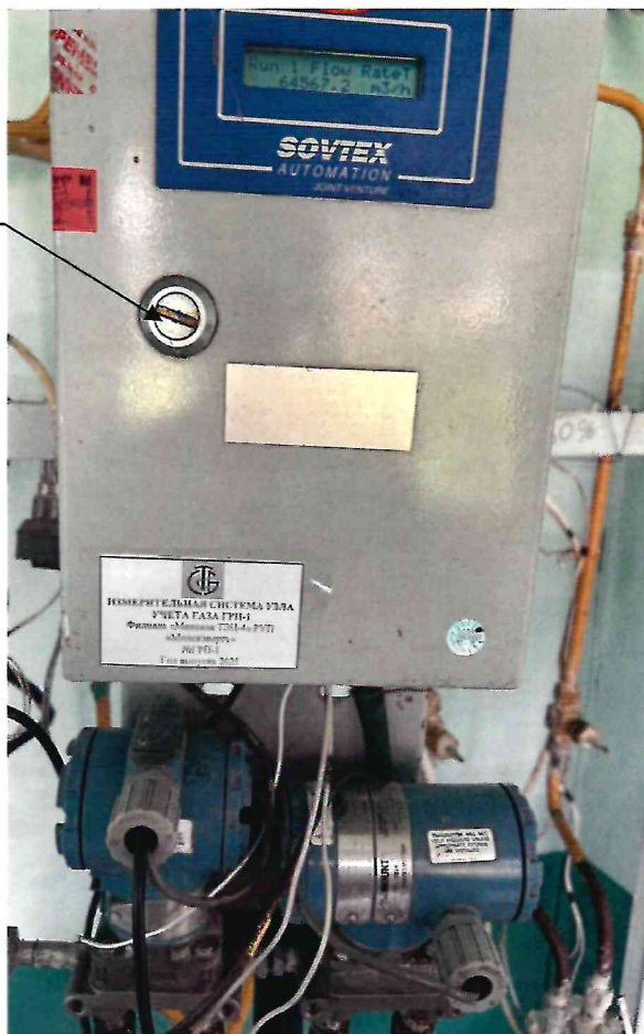
Рисунок 3.1 – Схема пломбировки от несанкционированного доступа
