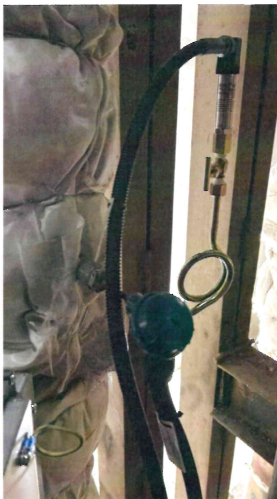
Рисунок 1.5 – Фотография термпреобразователя сопротивления ТС-Б-У и преобразователя давления измерительного РС-28.
