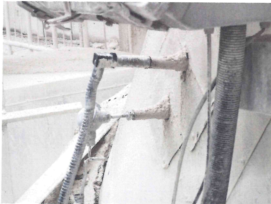
Рисунок 1.3 – Фотография преобразователя давления и термопреобразователя. Система автоматизированная контроля выбросов № ECS-24.415-01
