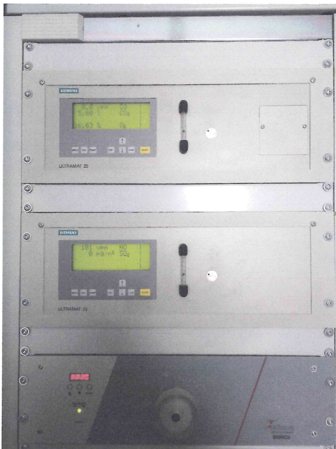
Рисунок 1.5 – Фотография газоанализатора. Система автоматизированная контроля выбросов № ECS-24.415-01
