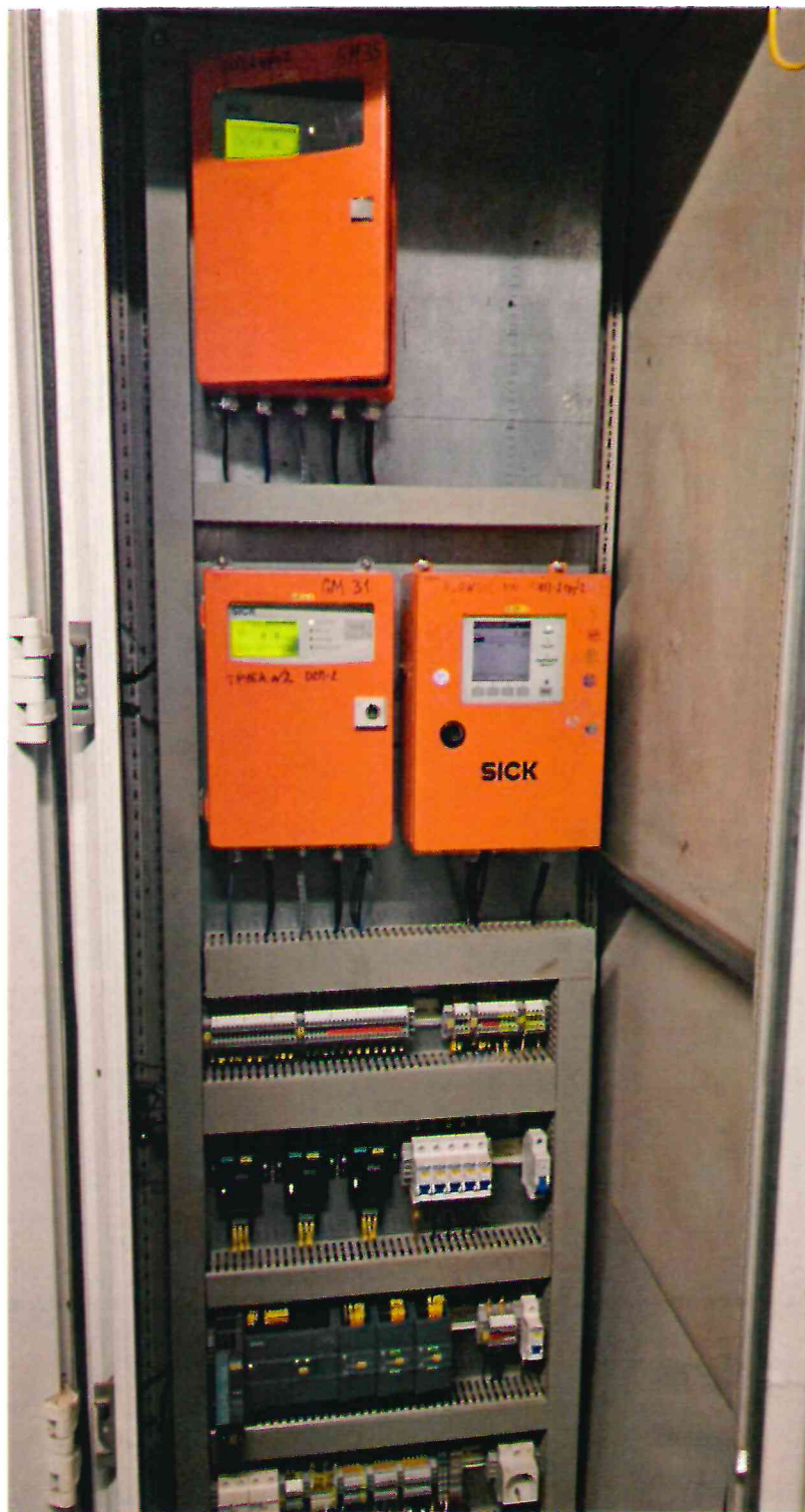
Рисунок 1.1 – Фотография общего вида. Система автоматизированная контроля и учета выбросов № СЭ.20322.АСК.003.УХЛ1 от дымовой трубы ДСП-2 ист. выбросов № 0765. ОАО «БМЗ» № СЭ.20322.АСК.003.УХЛ1
