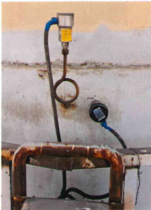
Рисунок 1.5 – Фотография преобразователя давления и термопреобразователя. Система автоматизированная контроля и учета выбросов № СЭ.20322.АСК.003.УХЛ1 от дымовой трубы ДСП-2 ист. выбросов № 0765. ОАО «БМЗ» № СЭ.20322.АСК.003.УХЛ1
