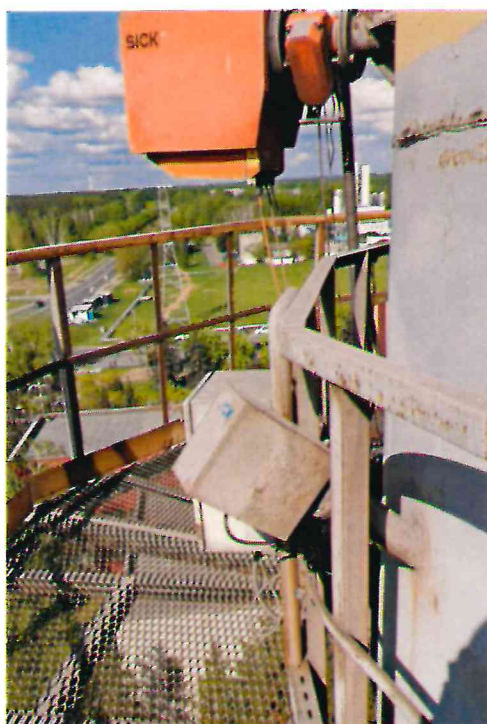
Рисунок 1.3 – Фотография датчиков измерителя скорости газового потока. Система автоматизированная контроля и учета выбросов № СЭ.20322.АСК.003.УХЛ1 от дымовой трубы ДСП-2 ист. выбросов № 0765. ОАО «БМЗ» № СЭ.20322.АСК.003.УХЛ1
