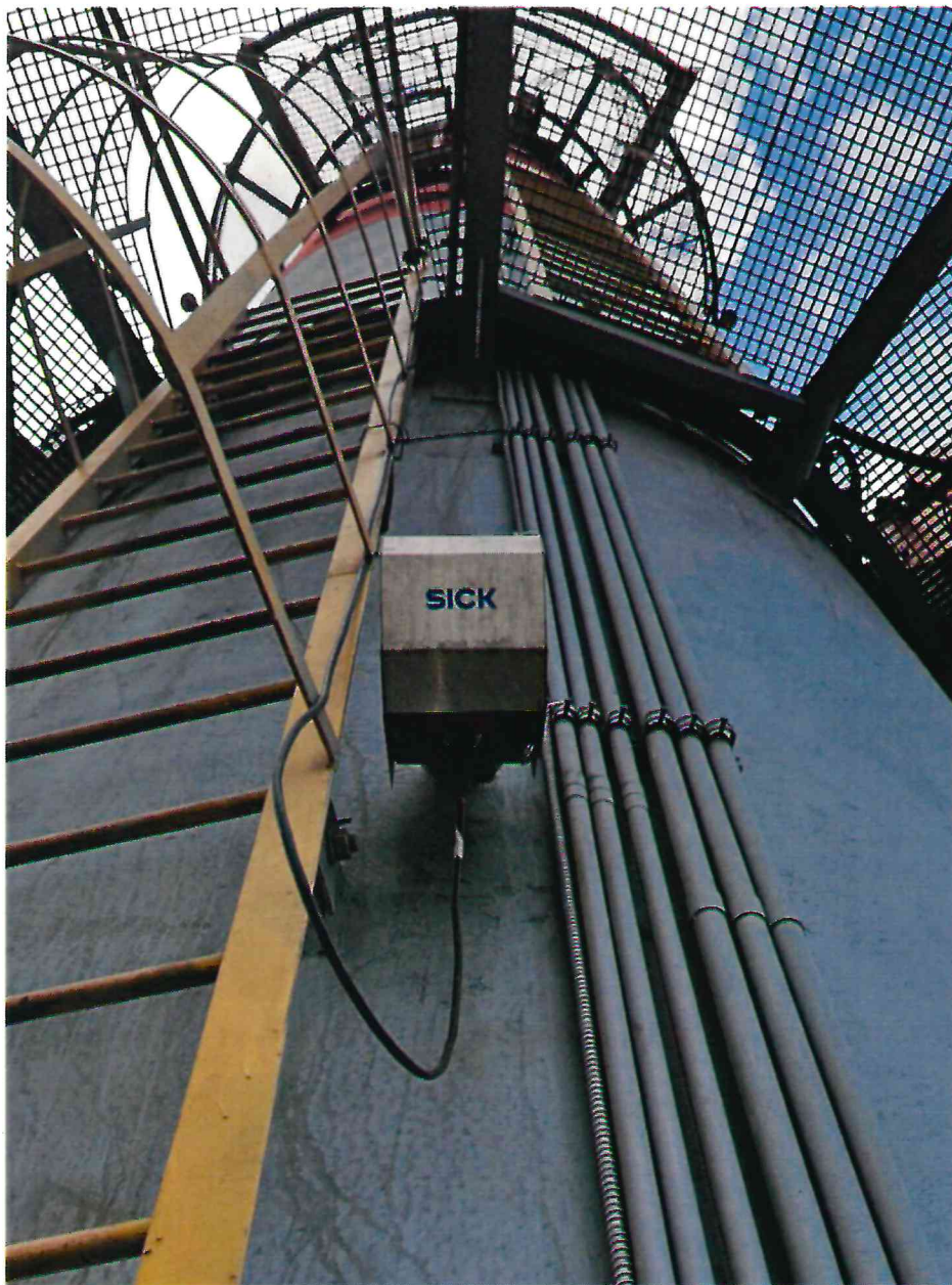
Рисунок 1.3 – Фотография датчиков измерителя скорости газового потока. Система автоматизированная контроля и учета выбросов № СЭ.20322.АСК.001.УХЛ1 от дымовой трубы ДСП 1 ист. выбросов № 0001. ОАО «БМЗ» № СЭ.20322.АСК.001.УХЛ1
