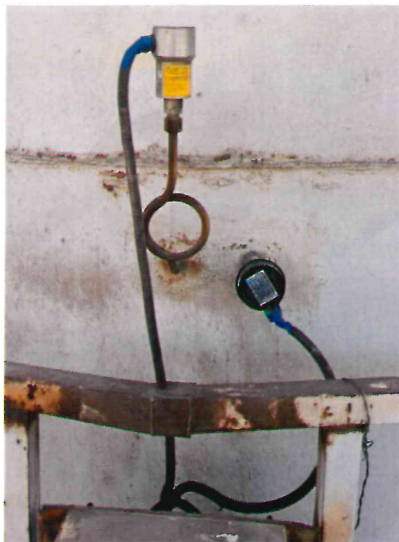
Рисунок 1.5 – Фотография преобразователя давления и термопреобразователя. Система автоматизированная контроля и учета выбросов № СЭ.20322.АСК.001.УХЛ1 от дымовой трубы ДСП 1 ист. выбросов № 0001. ОАО «БМЗ» № СЭ.20322.АСК.001.УХЛ1
