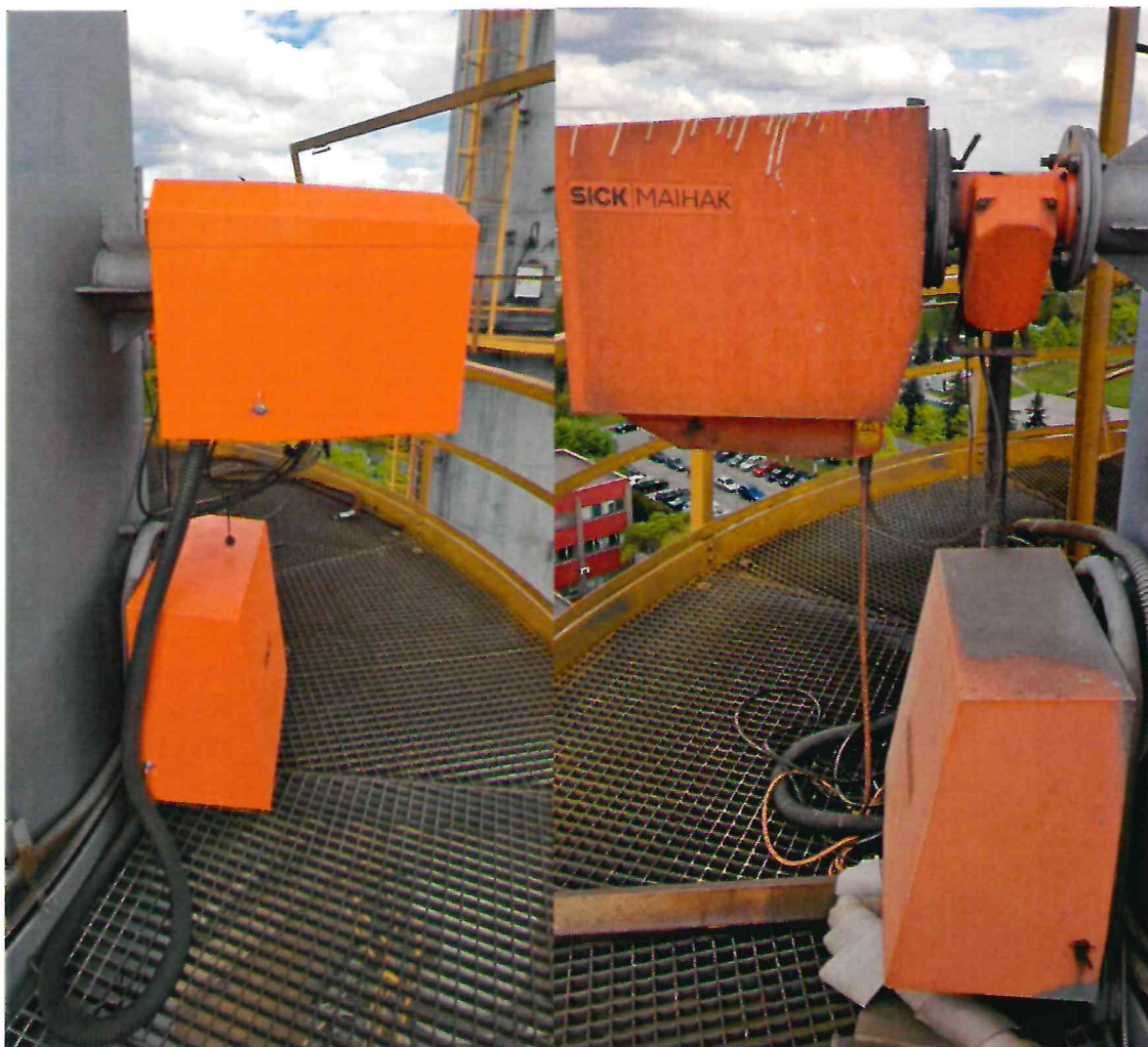
Рисунок 1.4 – Фотографии датчиков газоанализатора беспробоотборного GM32 и GM35. Система автоматизированная контроля и учета выбросов № СЭ.20322.АСК.001.УХЛ1 от дымовой трубы ДСП 1 ист. выбросов № 0001. ОАО «БМЗ» № СЭ.20322.АСК.001.УХЛ1
